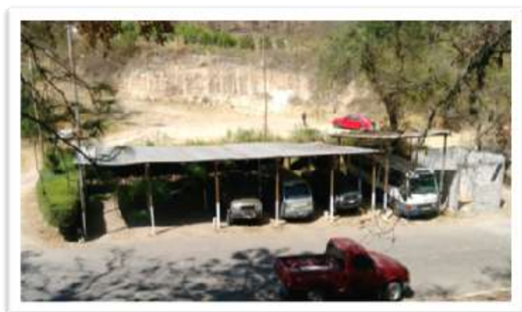
Figura 81 PARQUEO CON CUBIERTA DE LÁMINA.
