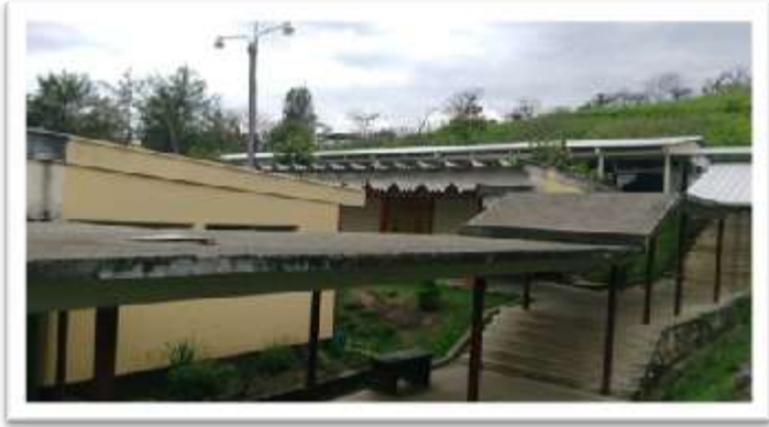
Figura 34 CORREDORES BAJO TECHO CONTRUIDOS CON ESTRUCTURA METÁLICA Y CUBIERTA DE CONCRETO.
