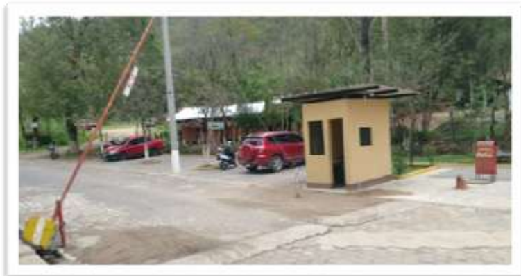
Figura 83 GARITA Y PARQUEO DE CLIENTES.
