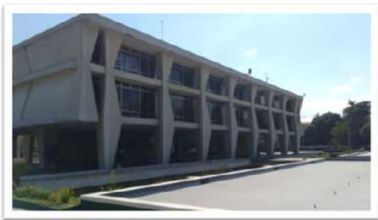
Figura 8 EDIFICIO DE LA RECTORÍA.
