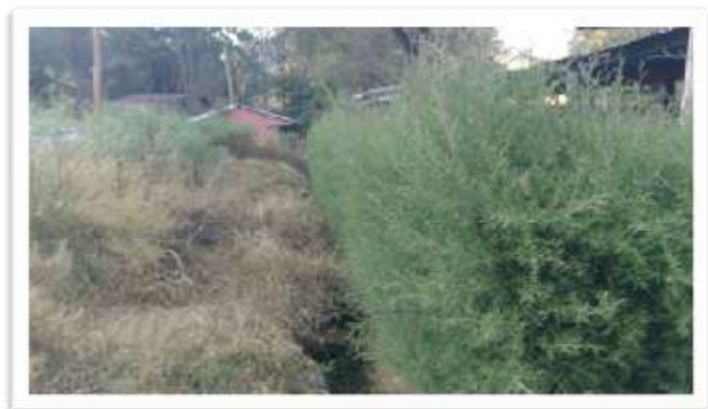
Figura79 ZANJÓN DE ESCORRENTÍA PLUVIAL.
