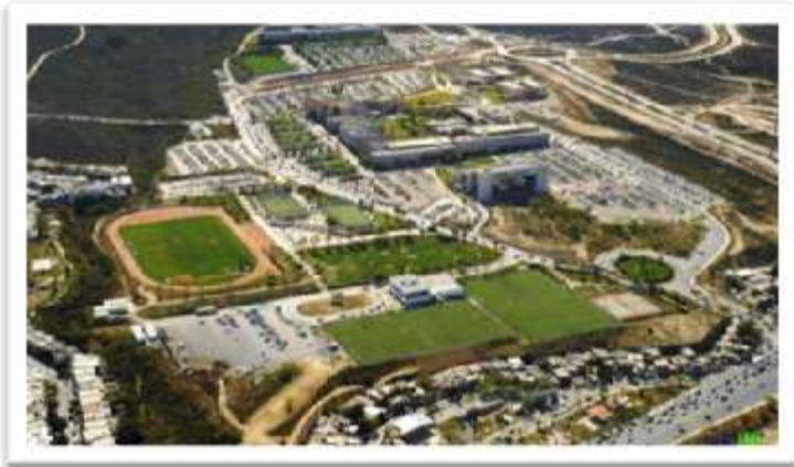
Figura 67 ÁREA DEPORTIVA UNIVERSIDAD DE MONTERREY.
