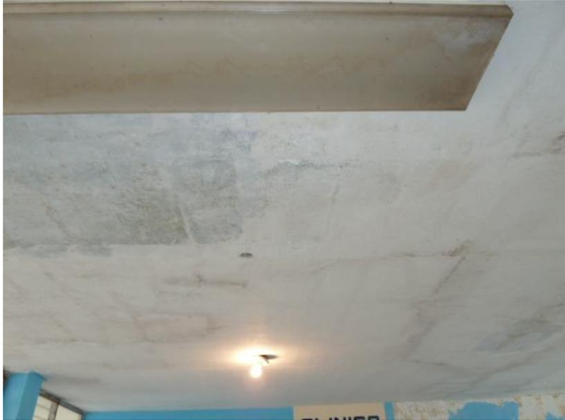
Sala de espera lista para recibir pintura, momento en que se detectaron Problemas de filtración en las paredes y terraza del Módulo.
