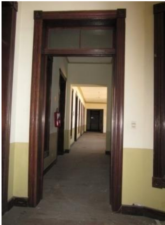
Corredor ala norte vista de E. a O.
