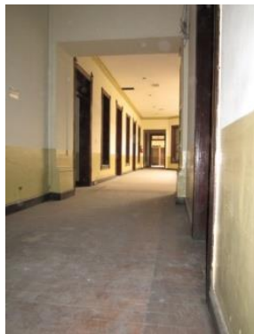
Vista general de paredes principales ala sur de O. a E
