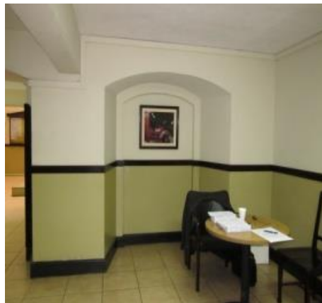
Nicho No. 4, en vestíbulo, vista de S. a N.
