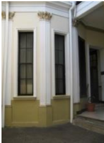
1) Ventanas y pilastras en octágono norte
