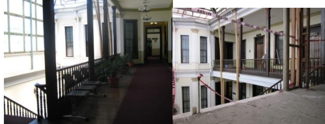
Vistas generales ala norte del 2do. Nivel.
