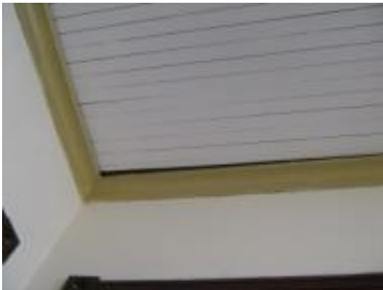
1) Cielo falso de machimbre blanco
