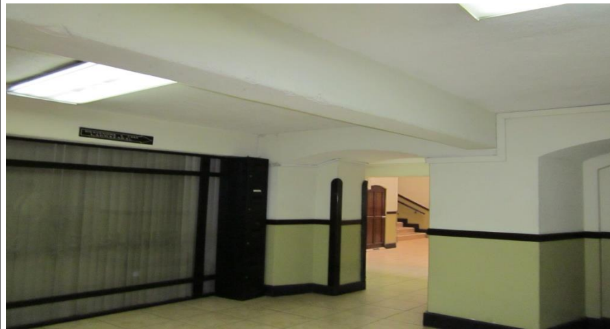
Vista general de la sección con el numeral del sótano, de SE a NO.
