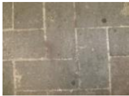
1) Piso en patio
