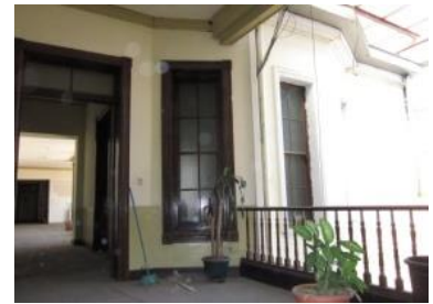
Baranda en octágono, 2do. nivel
