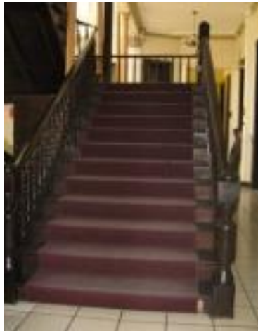
2) Gradas que conducen al segundo nivel
