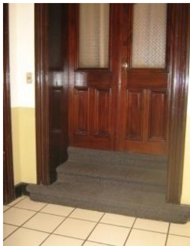
Puerta ubicada en octágono sur
