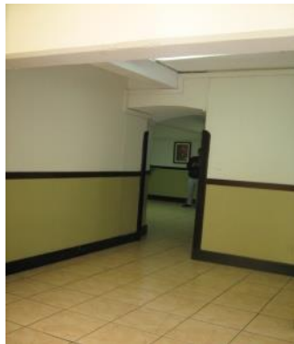
Piso en vestíbulo área No. 3, vista de NO. a SE.
