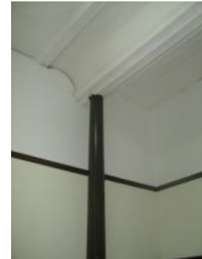
Parte superior de zócalo en oficina
