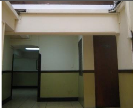
Muro sur y cubículo de tabla yeso, vista de N. a S.
