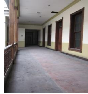
2) Vista general ala sur de O. a P.
