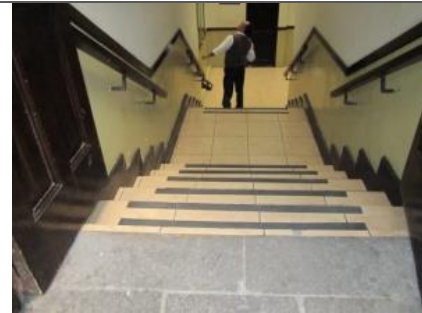
Gradas, vista de O. a E.
