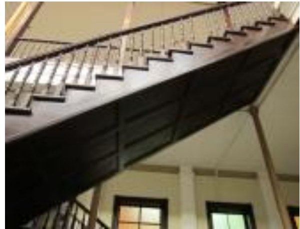
3) Vista de gradas, desde el primer nivel
