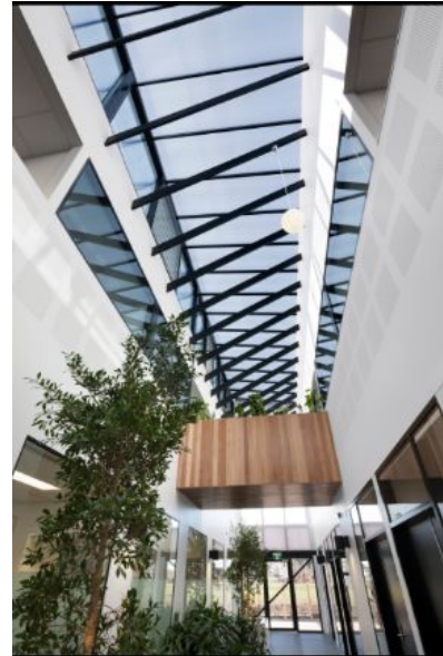
Figura 43: Vista a la Cubierta Fuente: www.archdaily.com
