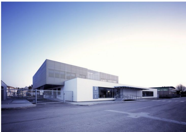
Figura 25: Fachada Centro de Salud Quintanar del Rey
