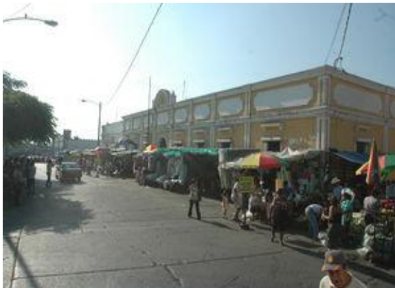
Figura 44: Edificio Municipal de Escuintla, fotografía propia. Noviembre 2014
