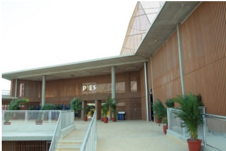
Ilustración 33: Colegio Pies Descalzos, parteluces.
