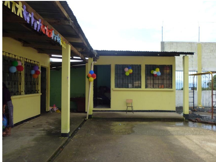
La colocación de balcones dio seguridad a las aulas del establecimiento.
