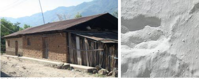
FIGURA No.130. Arquitectura vernácula Jacaltenango. Utilización de encalado. Fuente: http://jacaltenango.es.tl/CULTURA,-IDENTIDAD-E-IDIOMA-POPTI-h-.htm (consultado en diciembre de 2015)
