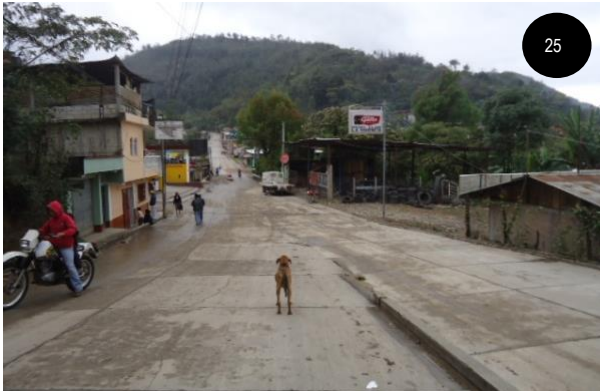
FIGURA No. 25. Análisis de sitio. DETALLES FÍSICOS ACTUALES: Calle principal de acceso al municipio, esta se encuentra pavimentada, se divide en 2 calles, una da al Cementerio General, la otra hacia la Escuela Dr. Epaminondas Quintana. Podemos ver un comedor a la derecha y un taller de herrería al fondo. Gráfica propia (2015)
