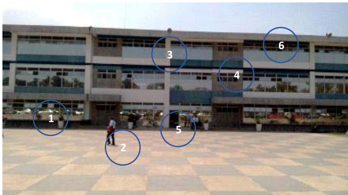
Imagen 33 DIGA. Fuente: Propia
