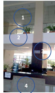
Imagen 34. Vestíbulo DIGA. Fuente:
