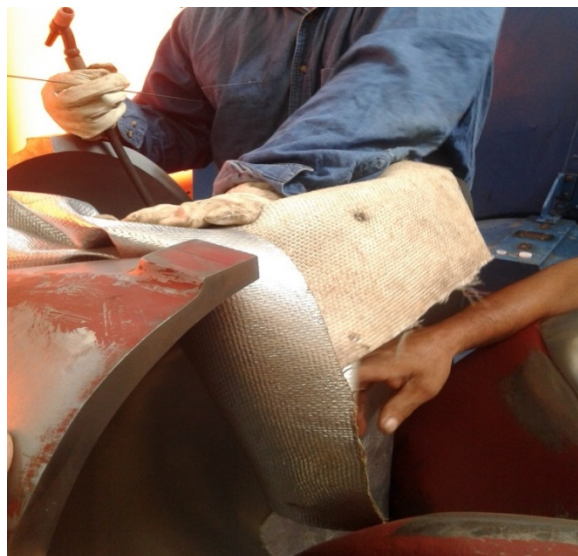
Figura 74. Colocación de manta refractaria para cumplir con el tiempo de permanencia
