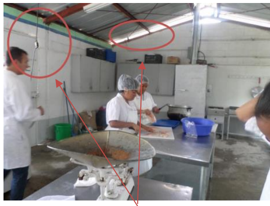
Fotografía No. 26 La iluminación y Ventilación Se realizan de manera natural, aunque cuentan con un sistema de electricidad, pero su falta de uso y de mantenimiento se ha deteriorado Fuente: Centro de Estudio del Mar y acuicultura
