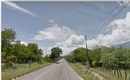
Fotografía 3. Elaboración propia, estudio de Campo. Vía principal Carretera CA-9, de los departamentos vecinos.
