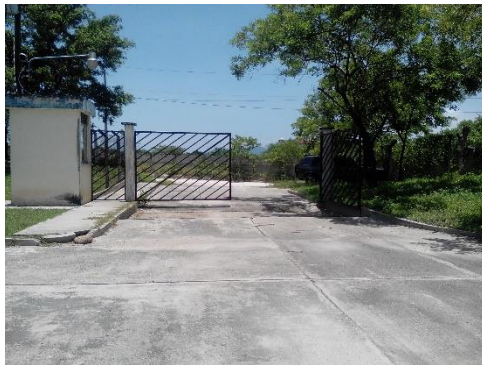
Fotografía 2. Elaboración propia, estudio de Campo. Ingreso principal al terreno garita de seguridad.
