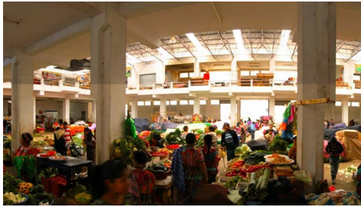
Ilustración 42 Apreciación de la estructura actual del Mercado Central. Fuente: Deguate.com.
