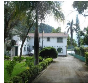
Imagen 29: Edificio desde ingreso principal.
