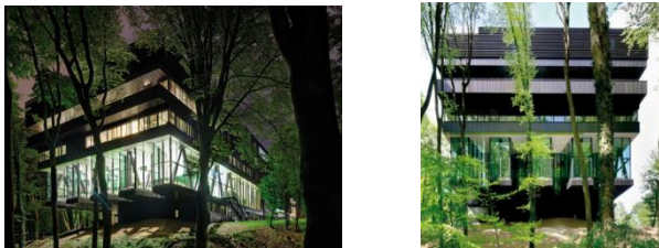
Imagen 22: Fachada en voladizo del edificio.
