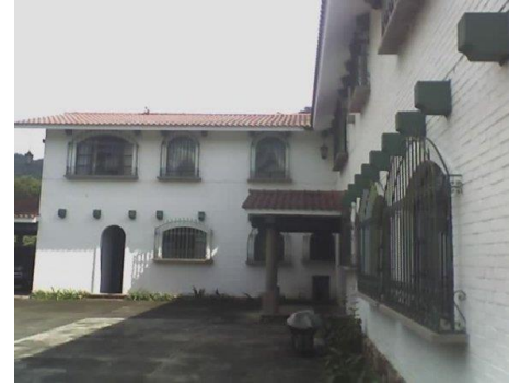
Imagen 30: Ingreso principal del edificio.
