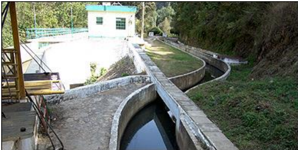
Figura 30. Represa el Tesoro. Fuente: EMPAGUA. 2014
