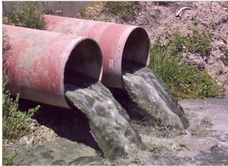
Figura 73. Descarga agua Residual, Rio Villa Lobos, 2011, Fuente © Marco Augusto Recinos
