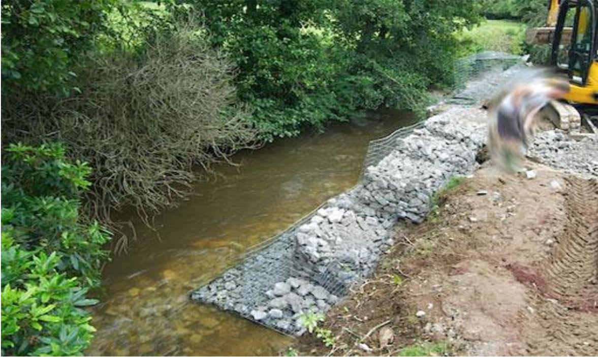
Figura No. 10 Modelo de gavión y colocación en ribera de río.
