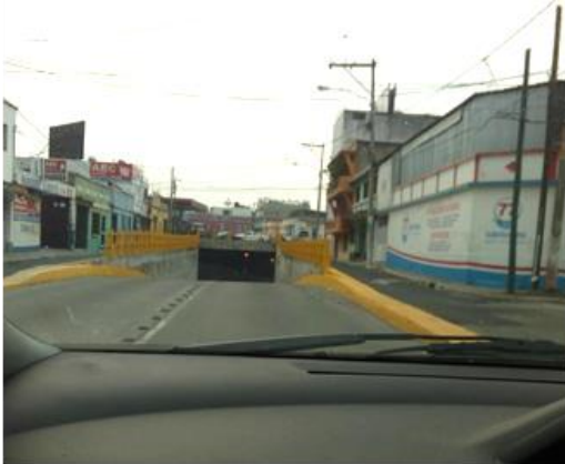
17. 12 calle ingreso a paso a desnivel
