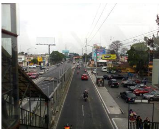
13. Calzada Aguilar Batres hacia el Sur
