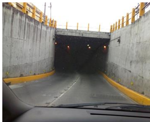
16. Paso a desnivel desde zona 12 a 13 calle
