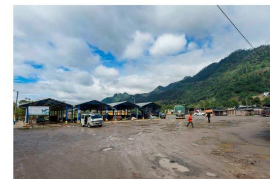
Fotografía 4 Se observa la infraestructura existente.
