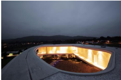
Ilustración 10. Se muestra el jardín interior desde una vista aérea. Fuente: https://www.plataformaarquitectura.cl/cl/02-27767/white-o-toyo-ito .
