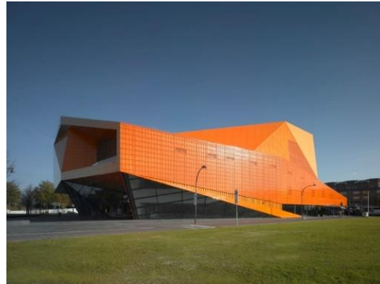
Ilustración 27. Fachada sur de Teatro Agora.
