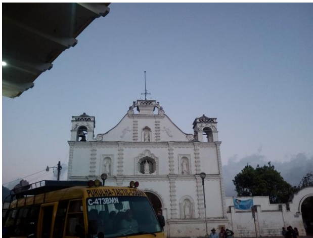
Ilustración 17. Fachada iglesia católica en el centro urbano de Tactic. Fuente: Propia.
