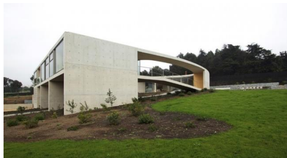
Ilustración 9. Se muestra la pendiente del terreno y la forma en la que se aprovechó. Fuente: https://www.plataformaarquitectura.cl/cl/02-27767/white-o-toyo-ito .
