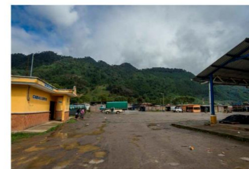
Fotografía 2 Se observa los sanitarios que estan a disposición de la gente y su ubicación.
