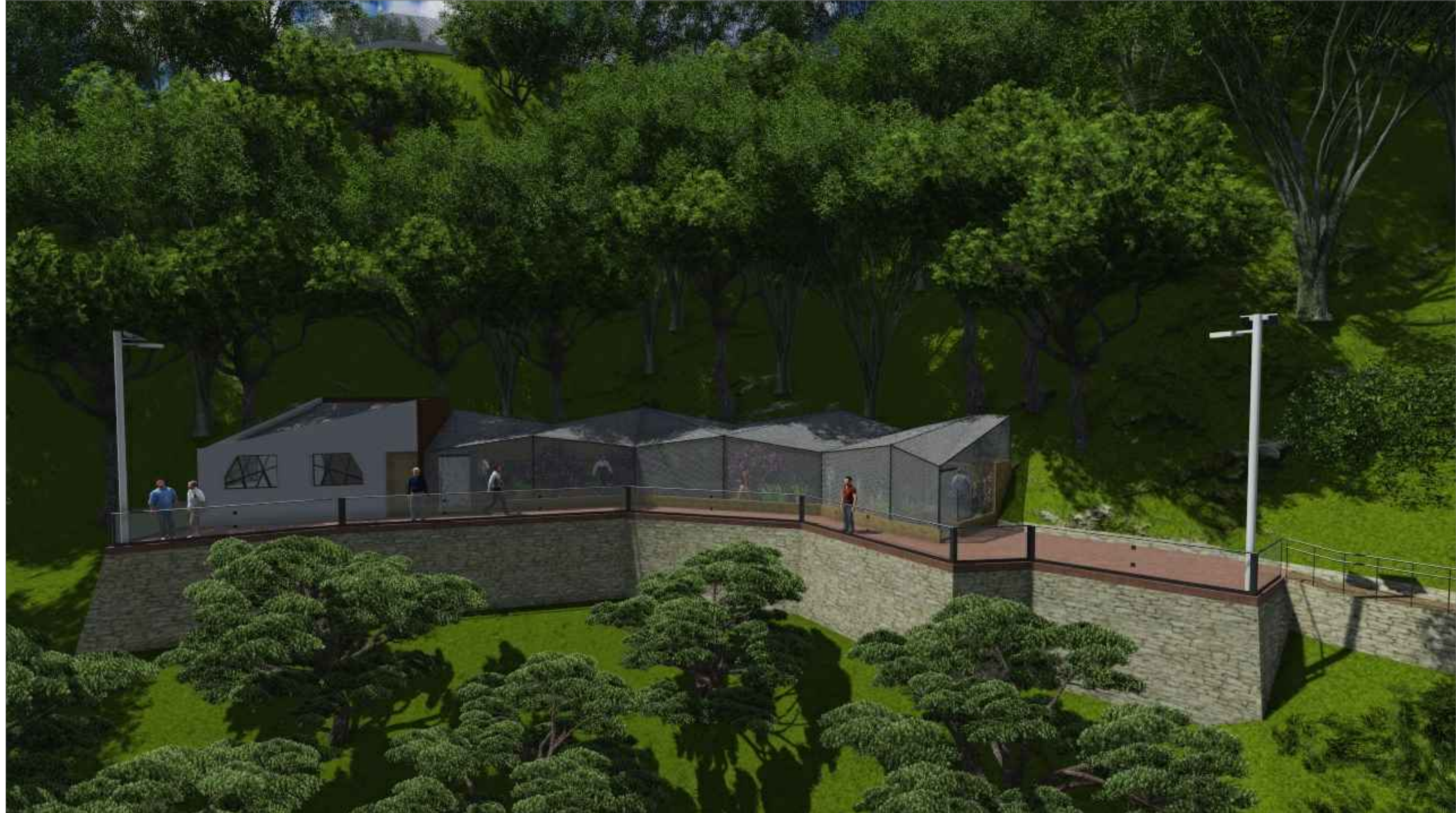
Vista Área de Módulo 3 - Oeste
