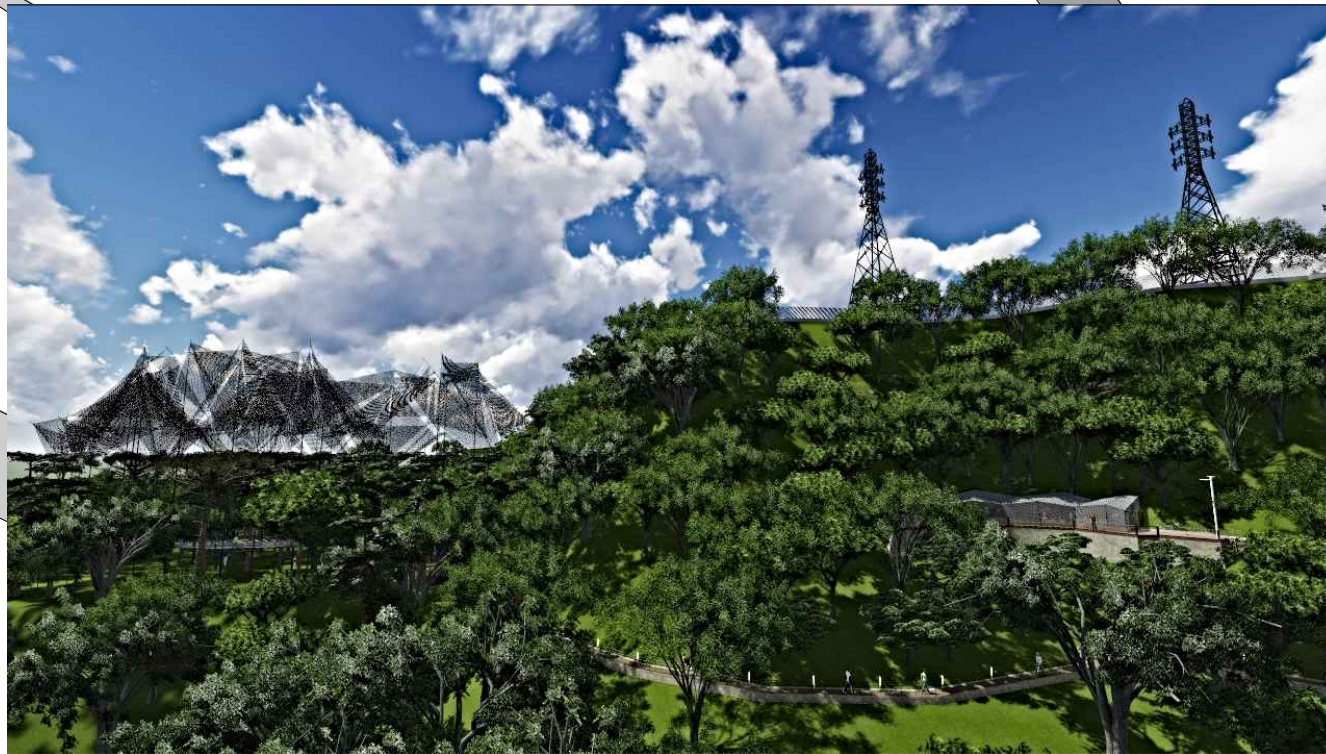
1). VISTA A MÓDULOS 3 Y 4
