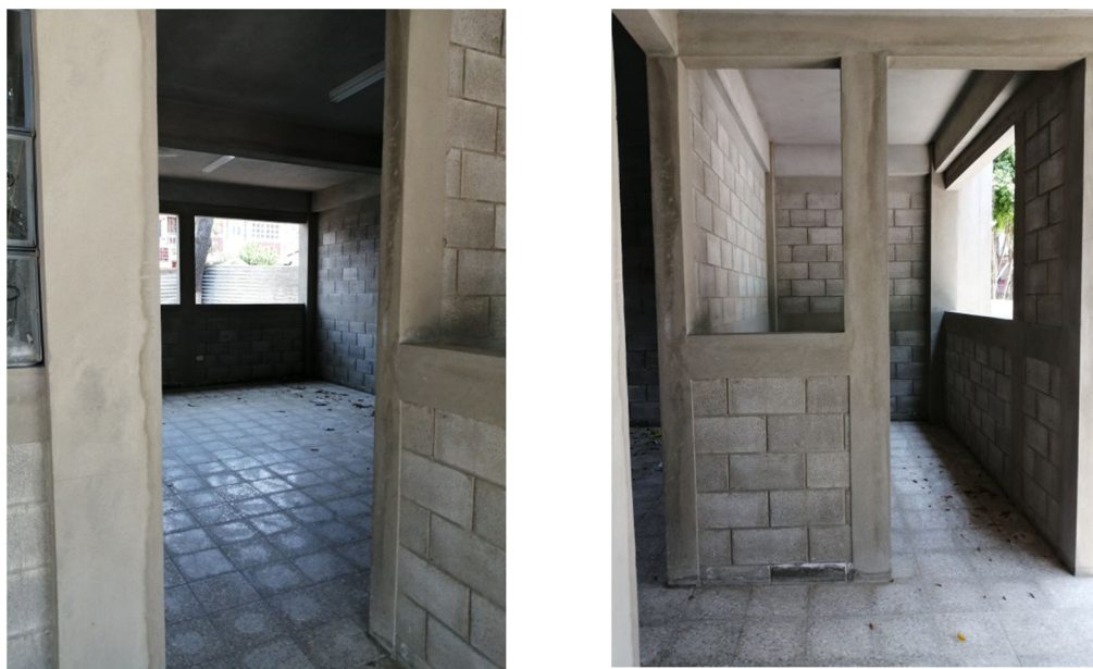
Figura No. 2. Remodelación tanto de aulas como de sanitarios, en obra gris.
