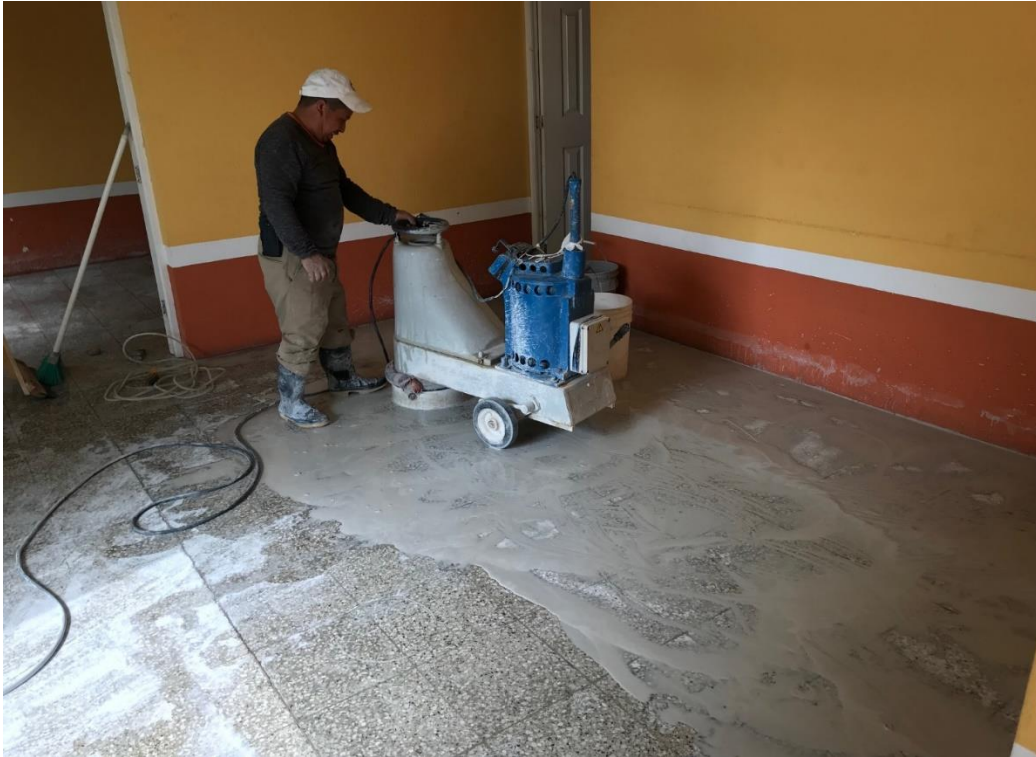
Fotografía 11. Pulido de piso en la sala de espera.
