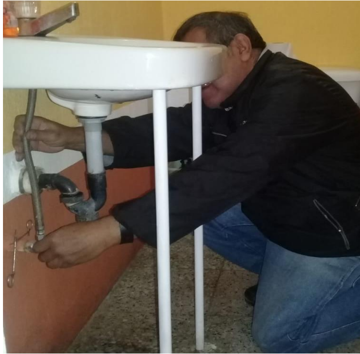
Fotografía 12. Reparación de la llave del lavamanos.
