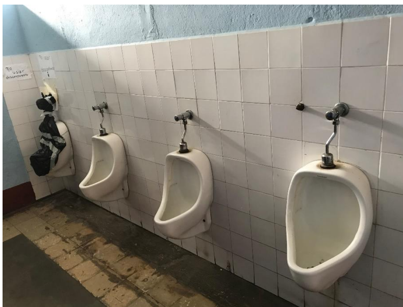
Foto 1. Fotografía previa al inicio del proyecto comunitario.
