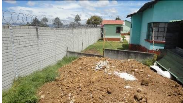
Imagen No.25 Área donde se ubica la fosa séptica. Elaboración: propia 2016.
