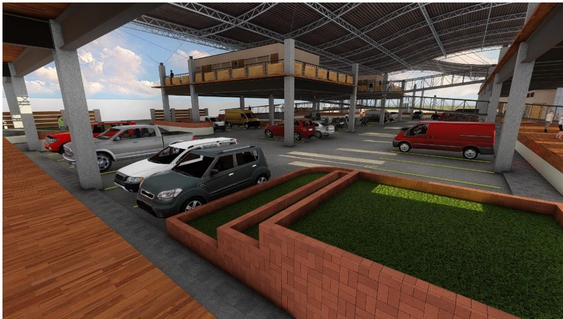
Imagen 94 Vista de Central de Abastos 7
