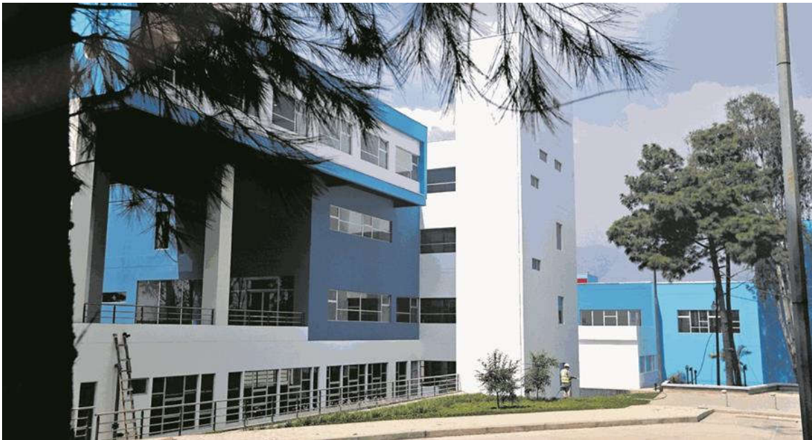
Figura 41. HOSPITAL NACIONAL DE VILLA NUEVA. En fase de construcción. https://qnwebprensalibrerootwest.s3.us-west-2.amazonaws.com/mmediafiles/pl/3f/3f23d245-7a6f-4ff5-ab58-f438dab8dff1_749_499.jpg Julio 2, 018
