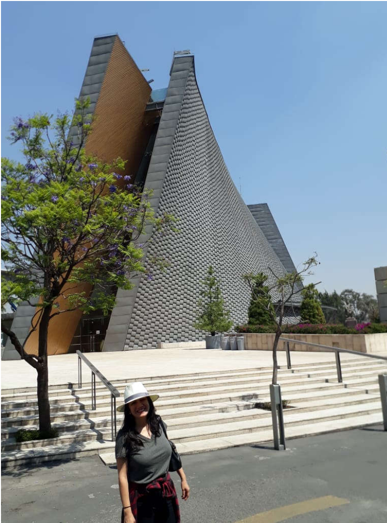
Figura 11. VISTA EXTERIOR DE INTEGRACIÓN IGLESIA Y CASA PARROQUIAL AL ÁREA URBANA Elaboración propia.
