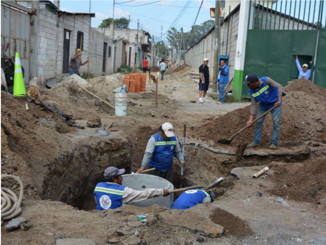
Figura 44. PROYECTO DE DRENAJES EN ZONA 6 DE VILLA NUEVA AÑO 2,017.
