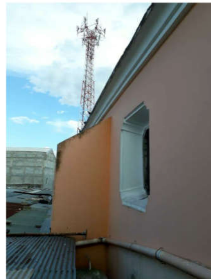
VISTA EXTERIOR CONTRAFUERTE DE PARROQUIA INMACULADA CONCEPCIÓN
