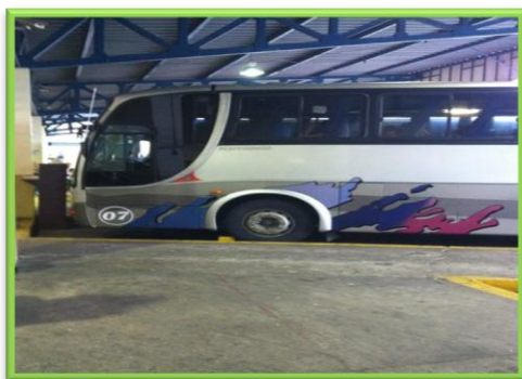
Estación de Buses Techado de andenes
