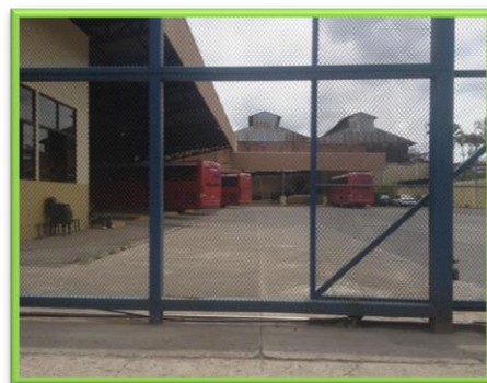
Cerramiento perimetral Simple y seguro
