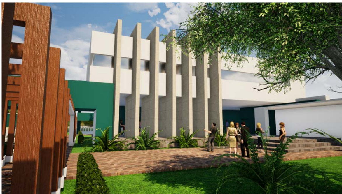
VISTA EDIFICIO DE BIBLIOTECA Y LABORATORIOS
