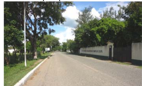
C1 Circulación de Ingreso 1 Fotografía No. 5.2.2 F3
