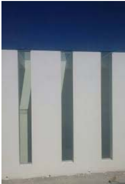
Ventanas tipo troneras. Fotografía No. 1.6.9 F1
