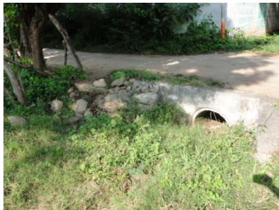
Paso de Agua Pluvial frente a terreno Foto No. 5.2.6 F2
