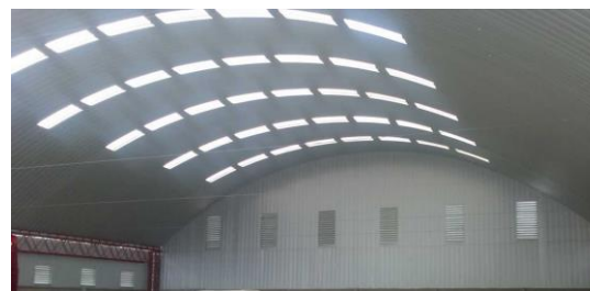
Cubierta tipo EMCO instalada.
