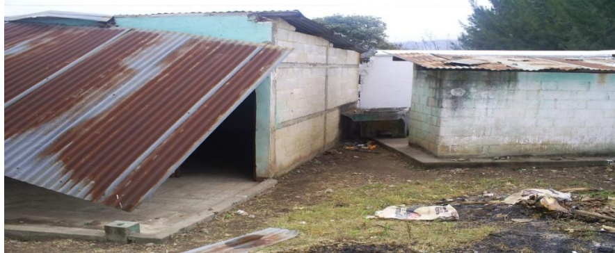
Imagen No. 8 Escuela Rural Mixta, Caserío Ciénega Grande
