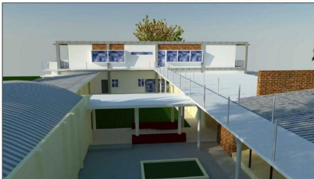
LATERAL ESTE EDIFICIO DE EXTENSION EDUCATIVA
