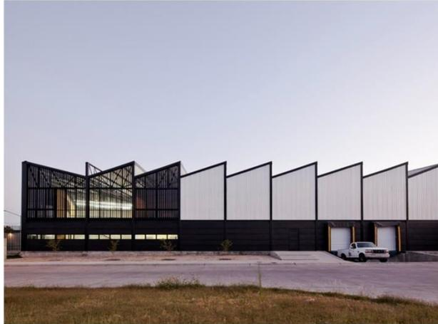
Utilización de acero en estructura y cubiertas para generar luces amplias sin interrumpir la función del proyecto con columnas intermedias.
