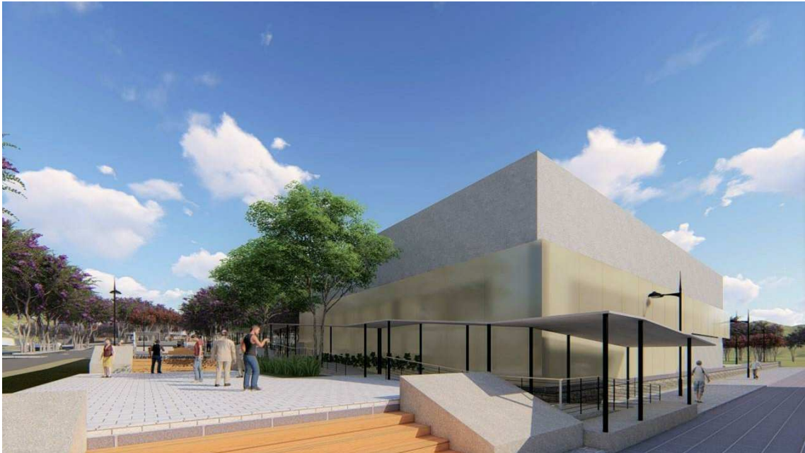
VISTA LATERAL NORTE
