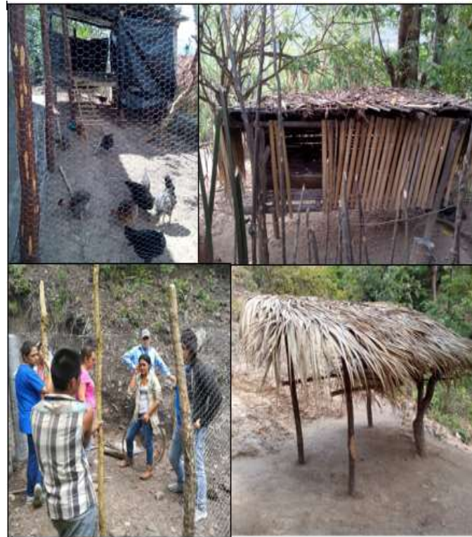
Figura 9: Construcción de instalaciones para aves
