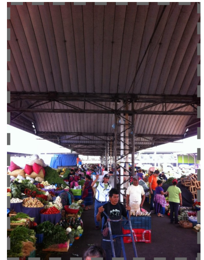
Galpones con estructura metálica. Por Roger H. Julio 2014
