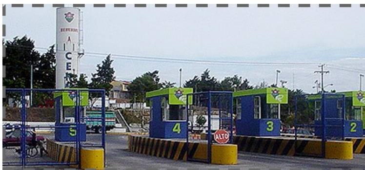
Ingreso vehicular. Por Diana Carrillo. Noviembre 2012.
