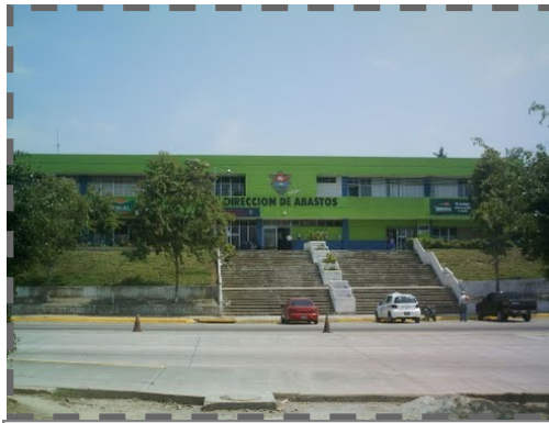
Área Administrativa. Municipalidad de Guatemala
