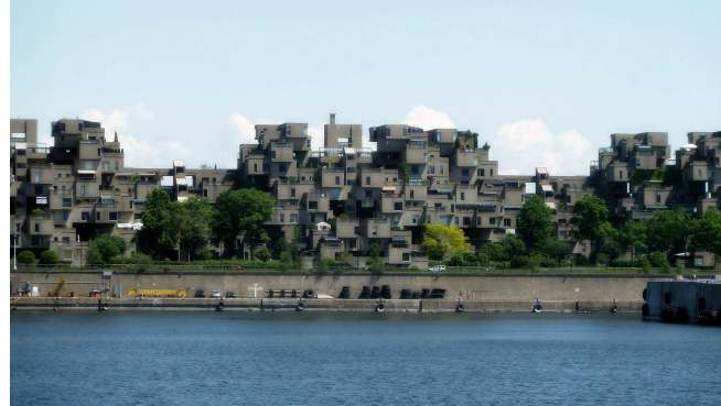
PERSPECTIVA FRONTAL DEL EDIFICIO
