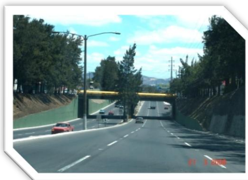
FOTOGRAFÍA No. 2: 31 Avenida Anillo Periférico hacia ZONA 1
