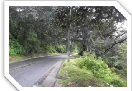
Servicio de electricidad y Teléfono
