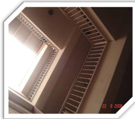
Módulos de gradas con iluminación cenital.
