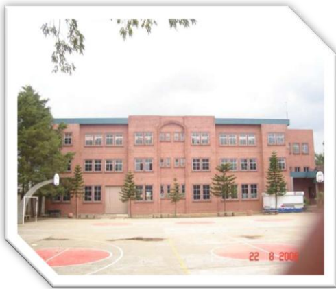
Las circulaciones entre edificios convergen en la cancha deportiva, la cual funciona como vestíbulo.
