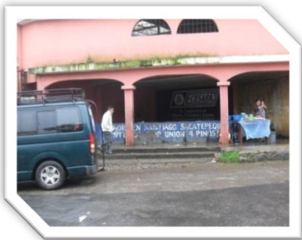
Pila Municipal de Santiago Sac. FOTOGRAFÍA 3
