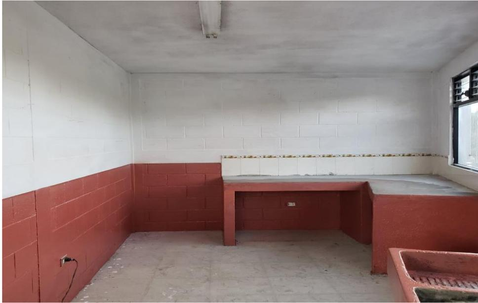
Imagen 5. Se observa cómo se pintaron el zócalo de la cocina, los mesones y la pila con la pintura de aceite color terracota. La parte superior se pintó con pintura látex blanca. Además se pintó el techo con pistola de presión.
