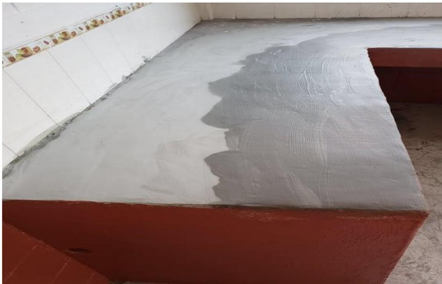
Imagen 6. Se desgastó el área descascarada de los mesones y se aplicó mezcla de cemento para regularizarla.
