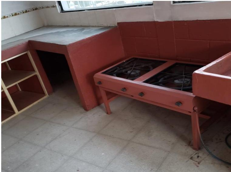
Imagen 4. Se observa cómo se pintaron el zócalo de la cocina, los mesones y la pila con la pintura de aceite color terracota. La estufa se lijó, se le trató con tiner y, finalmente, se pintó del mismo color con pistola de presión.
