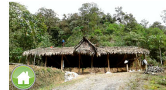
Fotografía elaboración propia
