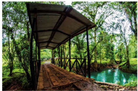
VISTA DE PUENTE VEHICULAR
