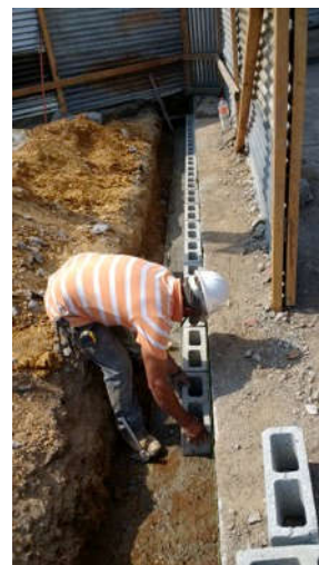
Figura 38 Construcción del Parque Central de Purulhá 2017
