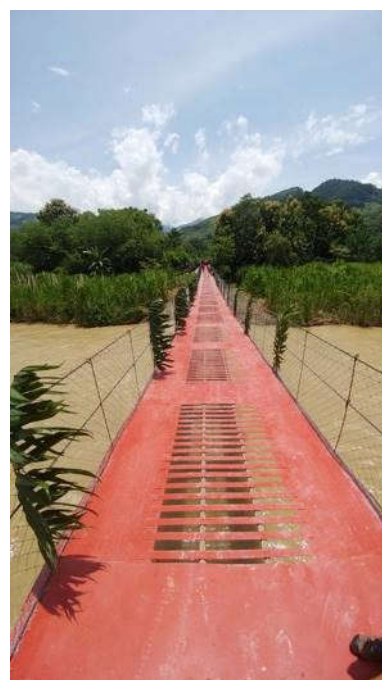
Figura 37 Puente peatonal colgante, Matucuy, Fotografía Propia
