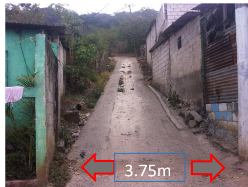
Foto No. 19, Vía Terciaria, 5ª calle, Fuente: Propia
