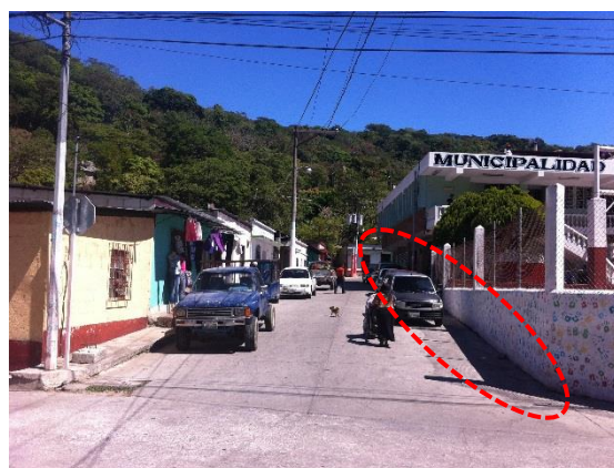
Foto No.57, Falta de banqueta, Fuente: Propia
