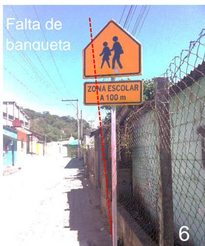
Foto No.34, Falta de acera para paso peatón 4ª calle y 3era avenida, Fuente: Propia
