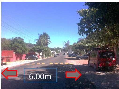
Foto No. 14, Vía Primaria CA-8, Fuente: Propia
