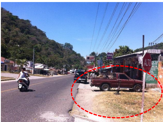
Foto No.60, Falta de banquetas y parqueos, Fuente: Propia
