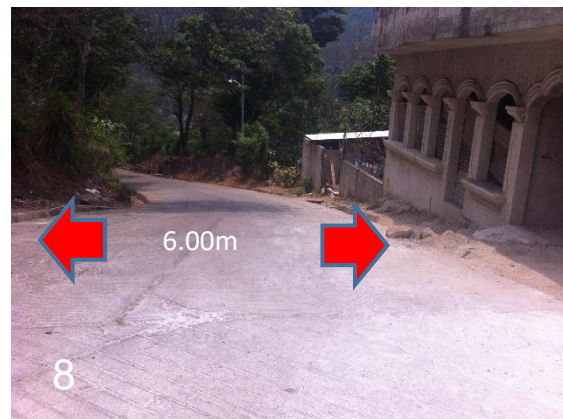
Foto No.45, Ingreso por la 5ª calle, Fuente: Propia
