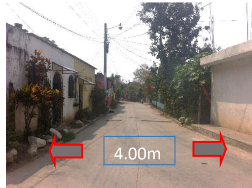
Foto No. 21, Vía Secundaria Ingreso, Fuente: Propia
