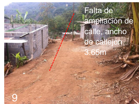
Foto No. 29, Callejón el Manzanal 6ª calle, Fuente: Propia
