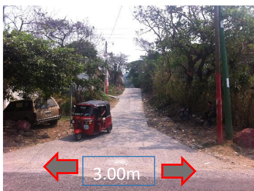
Foto No. 18, Calle al Mangón, Vía Secundaria, Fuente: Propia
