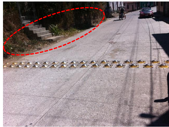
Foto No.67, Falta de banquetas, Fuente: Propia
