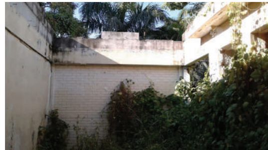
ÁREA DE JARDÍN CON CRECIMIENTO ABUNDANTE DE VEGETACIÓN. LOS MUROS SE ENCUENTRAN EN CONDICIONES ADECUADAS PARA SER REUTILIZADOS EN LA NUEVA PROPUESTA
