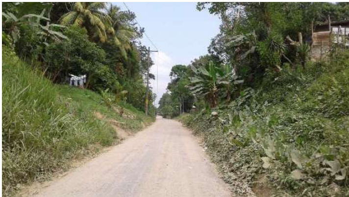
SECTOR ENTRE MILLA 6 – 7: Se encuentran algunas invasiones entre las áreas que cuentan con mayor vegetación.
