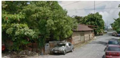
CASA DEL GÜICO: Segunda estación del ferrocarril, se ubica en la 8ª Avenida y 13 calle de Puerto Barrios, actualmente se encuentra deshabitada.
