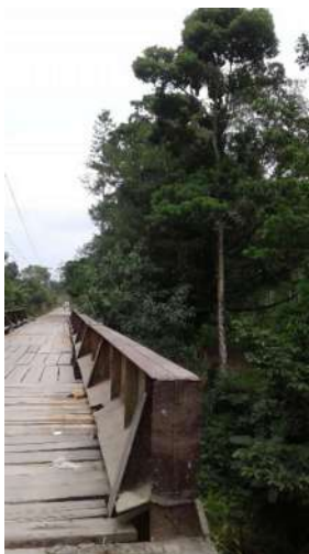
PUENTE MILLA 3: Se encuentra en la parte superior de uno de los riachuelos que se comunican con el tramo ferroviario, fue reconstruido con madera para permitir el paso de un extremo a otro.
