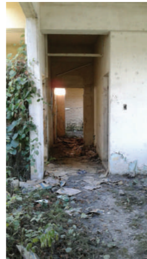
INTERIOR DE LA EDIFICACIÓN, SE ENCUENTRAN DAÑOS EN EL REVESTIMIENTO DE LOS MUROS, BASURA ACUMULADA Y CRECIMIENTO DE VEGETACIÓN
