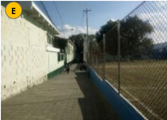
Figura 76. Caminamiento peatonal existente que colinda con el terreno.
