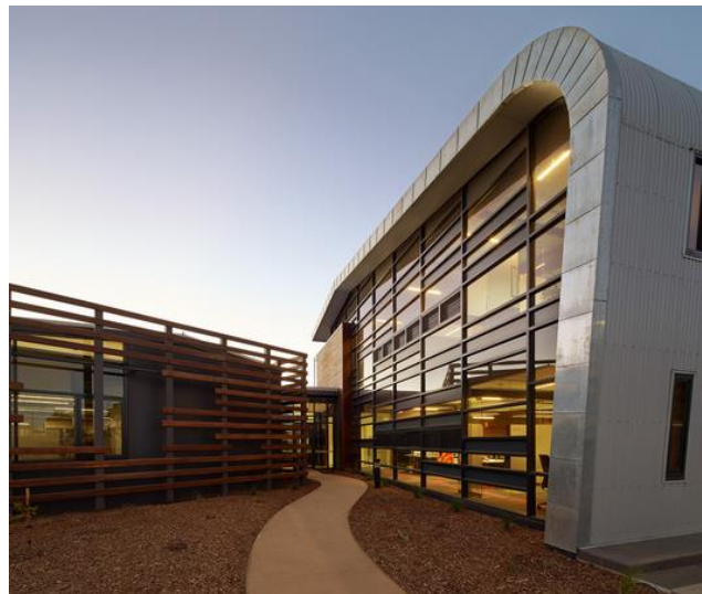
Figura 43: Vista lateral-segundo ingreso al edificio
