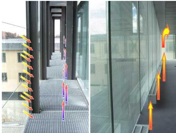
Figura 19: Cámara acristalada (circulación del aire) y sistema de distribución de calor.
