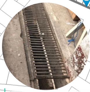
Fotografía no. 201 Canaleta de drenaje de Aguas pluviales
