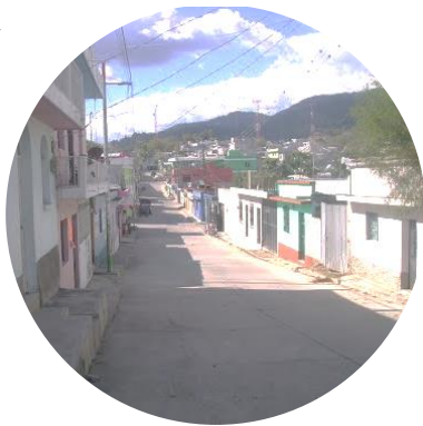
Tipología de viviendas urbanas Fotografía no. 13
