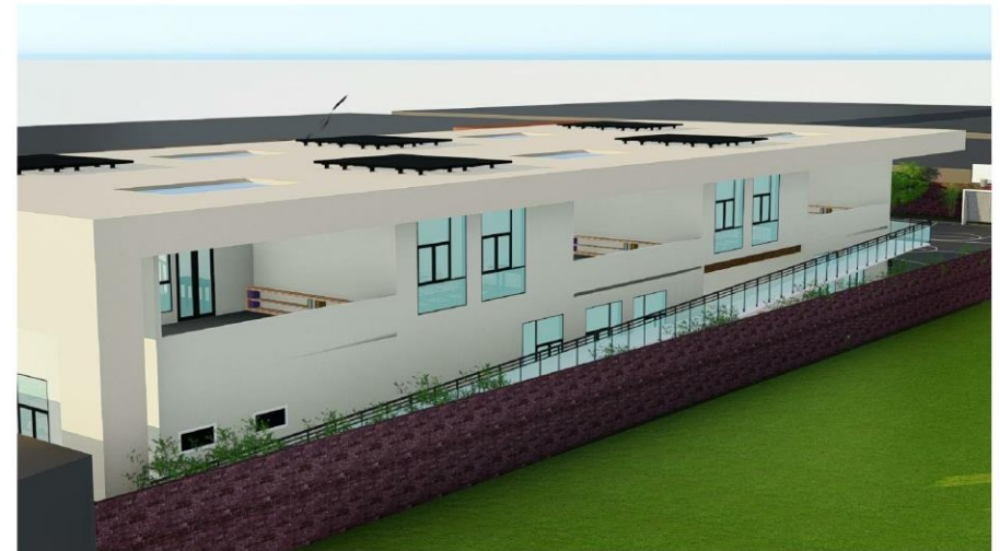
Vista Posterior Aulas Escolares
