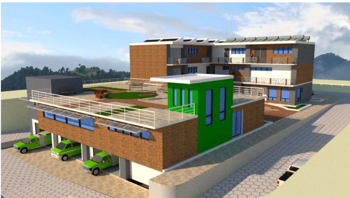
VISTA EXTERIOR SUROESTE ESTACIÓN DE BOMBEROS
