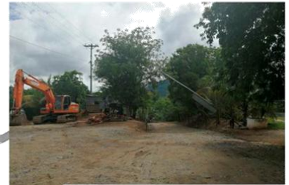
CALLE PRINCIPAL DESDE EL CASCO URBANO
