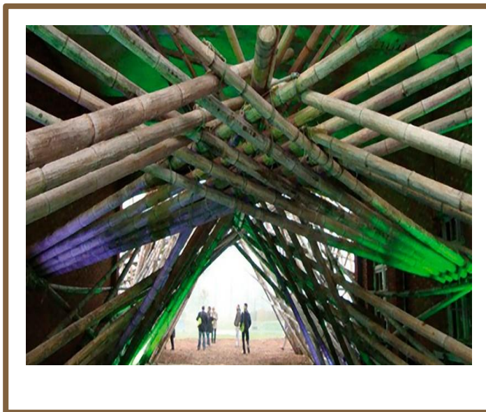
Fig.16 ("El Bambú Guadua Como Material Alternativo - Ecohabitar" 2019)
