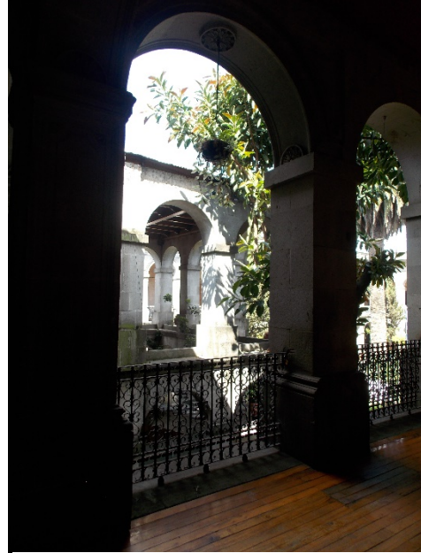
Ilustración 42, Arcos de segundo nivel, Municipalidad de Quezaltenango, fuente propia, 2018.
