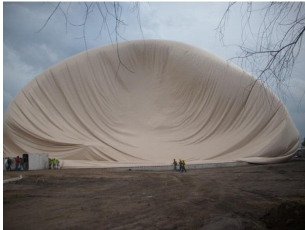
Figura 63. Proceso de inflado de formaleta, expuesta a ráfagas de viento
