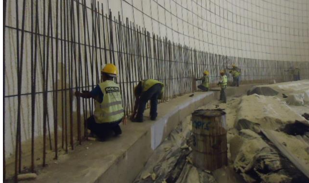
Figura 70. Colocación de acero estructural
