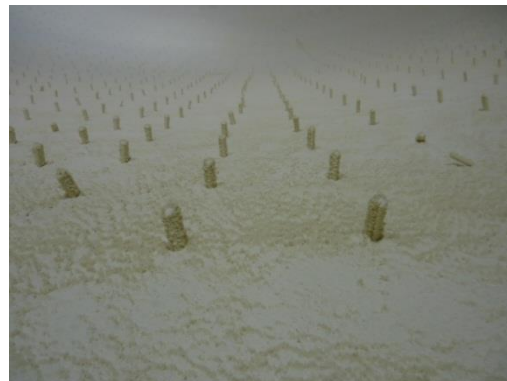
Figura 68. Sujetador de barras de refuerzo b) Distribución de sujetadores sobre superficie
