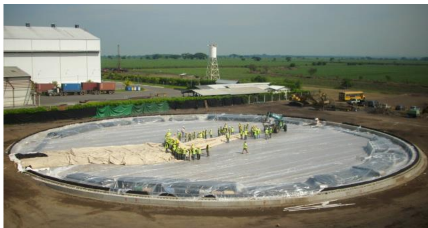
Figura 56. Despliegue longitudinal de formaleta inflable
