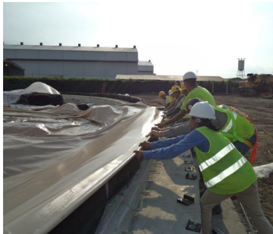
Figura 59. Estiramiento de formaleta previo a su sujeción
