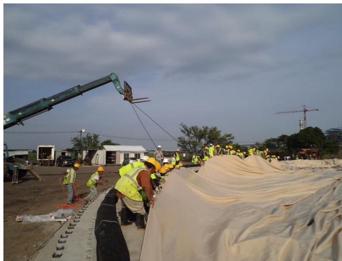
Figura 52. Sujeción de formaleta inflable a viga anular
