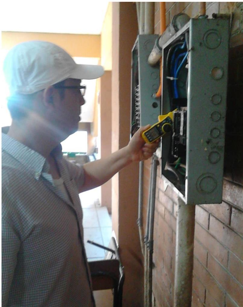
**Figura 4. Durante la medición de amperaje en panel de circuitos eléctricos del nivel uno del módulo I del CUNSUROC.**
