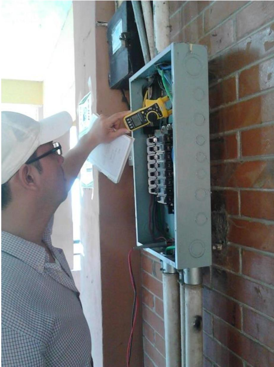
**Figura 18. Durante la utilización de multímetro para medición de amperaje y voltaje en paneles de control eléctrico.**
