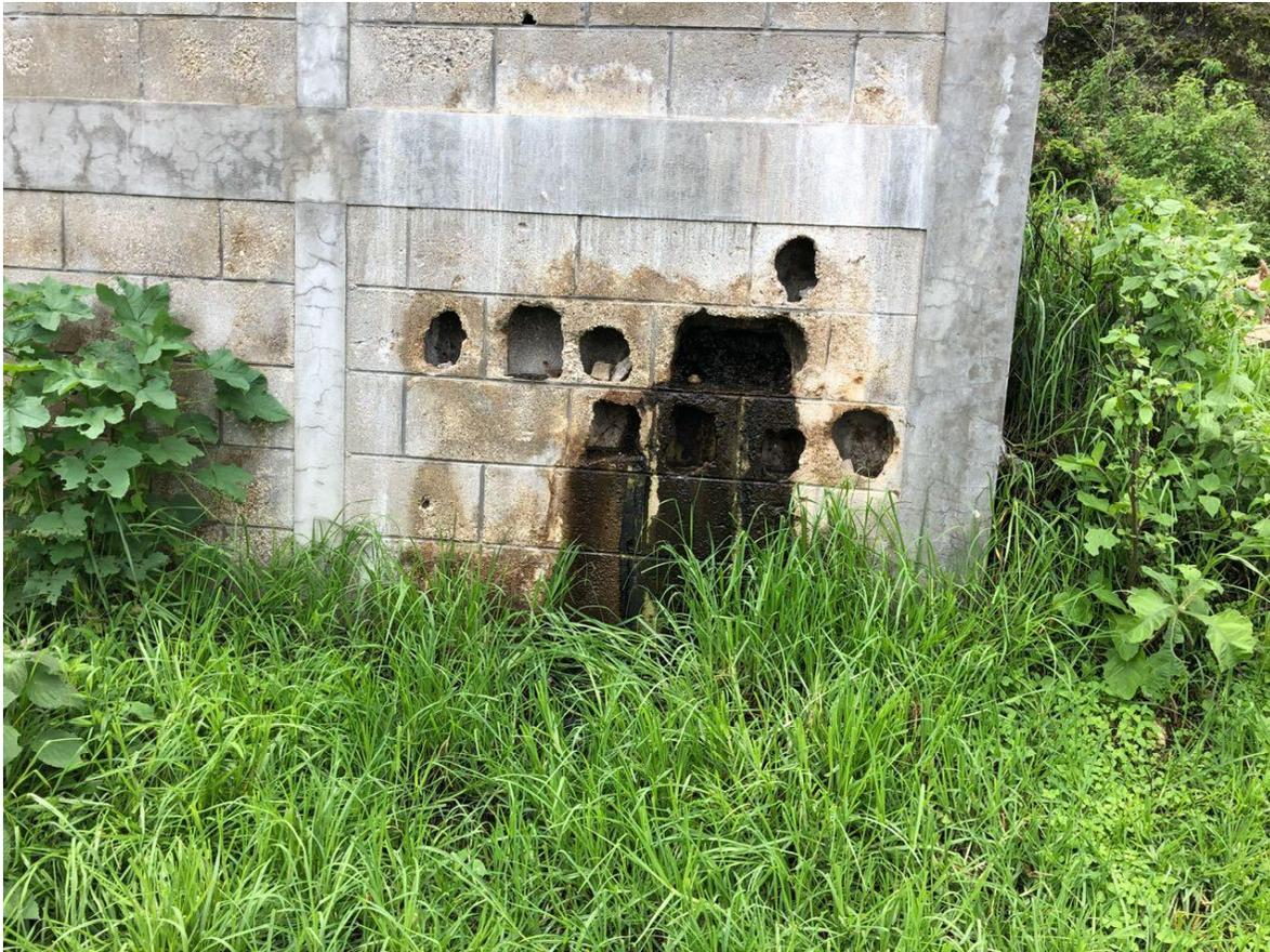
*Figura 9. Abertura de la estructura para la salida de lixiviados. Fotografía: Flory Imeri, 2018.*
