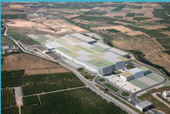
Ilustración 22 Vista del conjunto de la PTRS Fuente: Plataforma arquitectura
