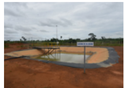
Ilustración 38 Laguna de dilución para el tratamiento de lixiviados Fuente: obtenido de la web
