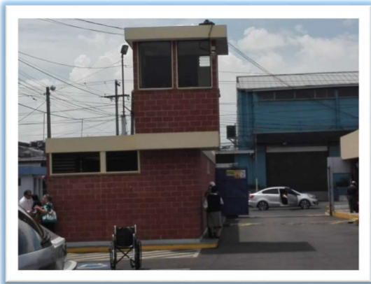
Fotografía 64, Atalaya Parqueo Asfaltado
