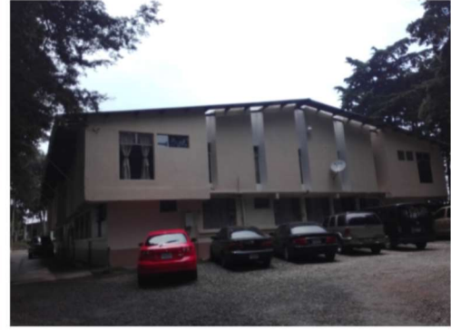
Fotografía 89, Fachada Frontal del Edificio Administrativo
