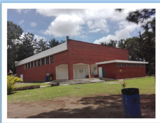
Fotografía 39, Ingreso Edificio Juvelim
