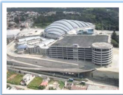
Fotografía 76, Torre de Parqueos Megafrater
