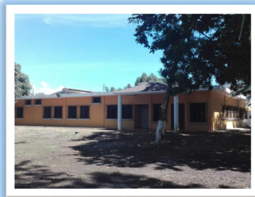
Fotografía 51, Edificio Casa Caleb 2
