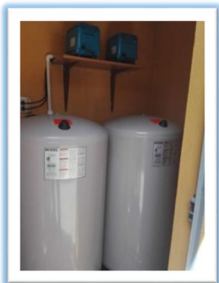
Fotografía 55, Sistema Hidroneumático
