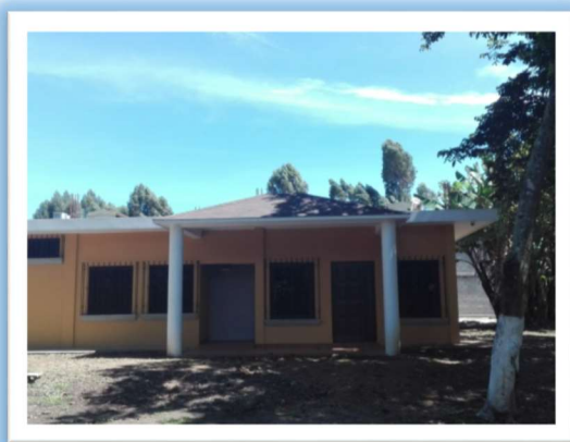
Fotografía 50, Edificio Casa Caleb
