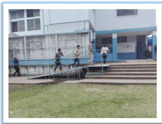
Fotografía 66; Rampa de acceso
