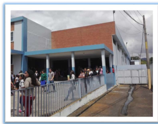
Fotografía 67, Barandillas de Seguridad
