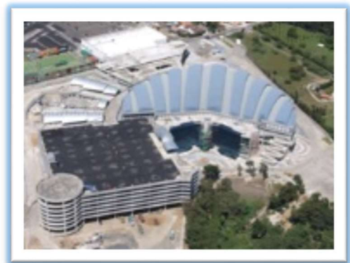
Fotografía 75, Torre de Parqueos Megafrater
